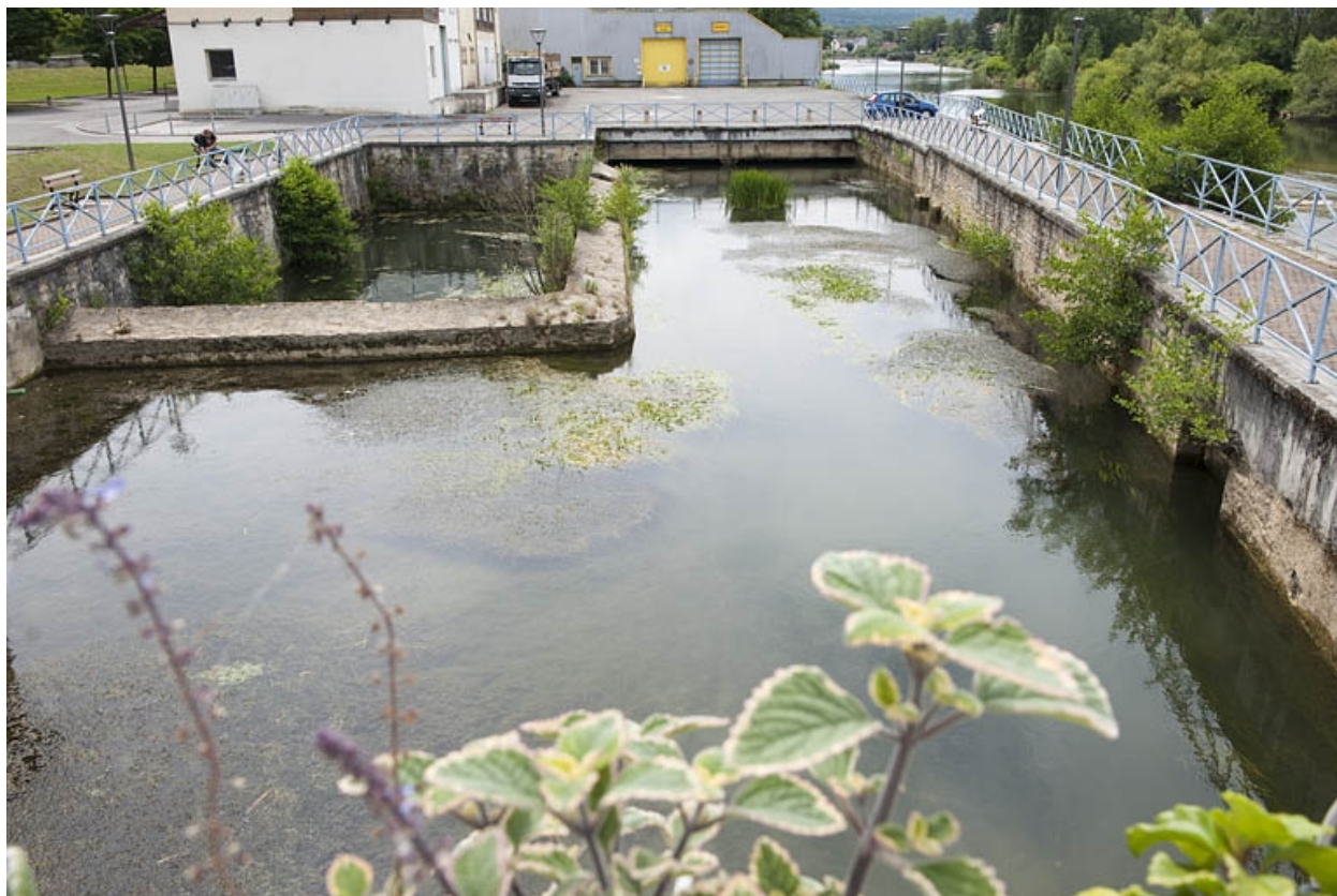
Bassin aménagé à l'emplacement du canal d'amenée.
