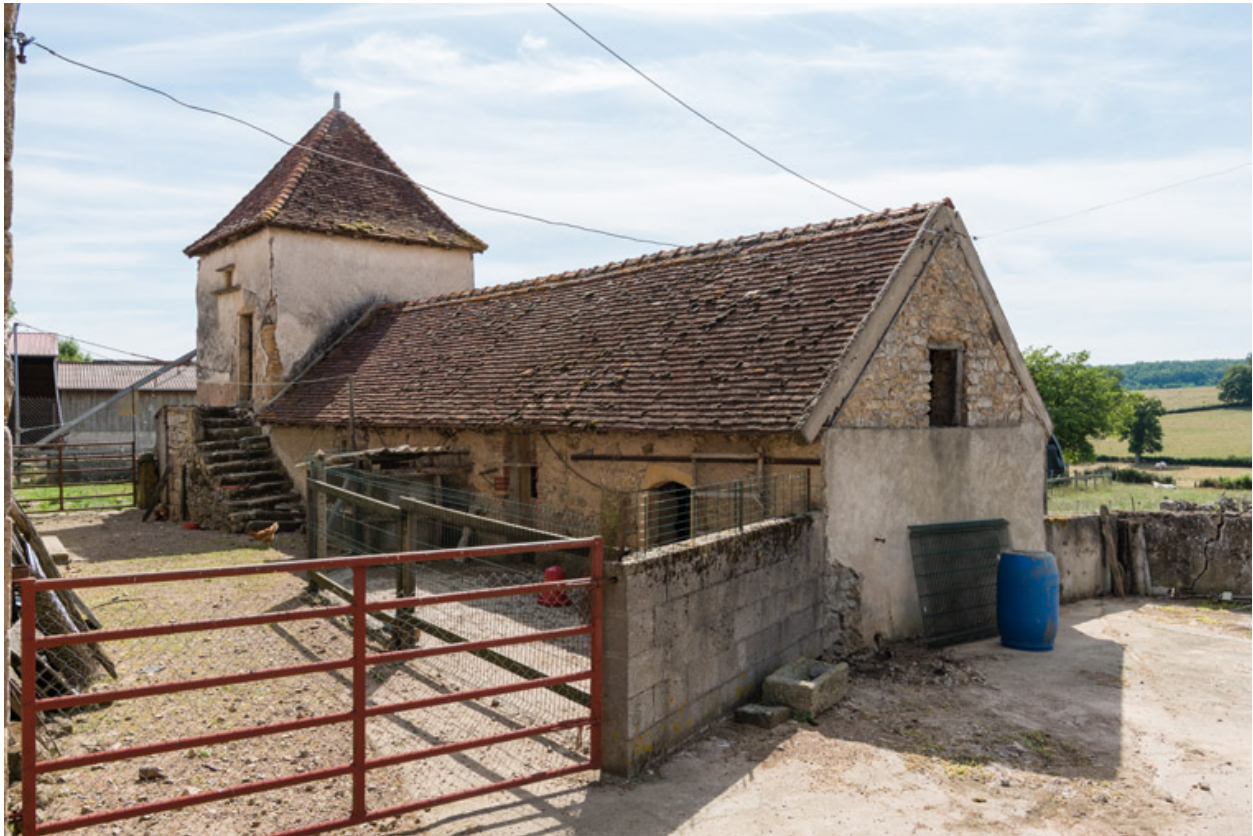
Bâtiment de dépendance composé d'un pigeonnier, d'un four à pain et de soues à cochons et poulailler
