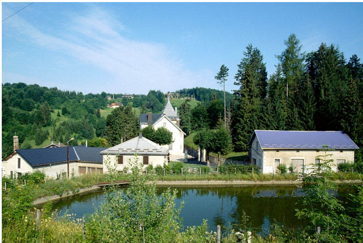
Bassin de retenue et façades sur rue.
