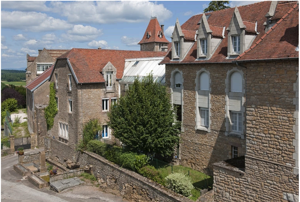
Bâtiment (A) et bâtiment (C), vue du côté rue.
