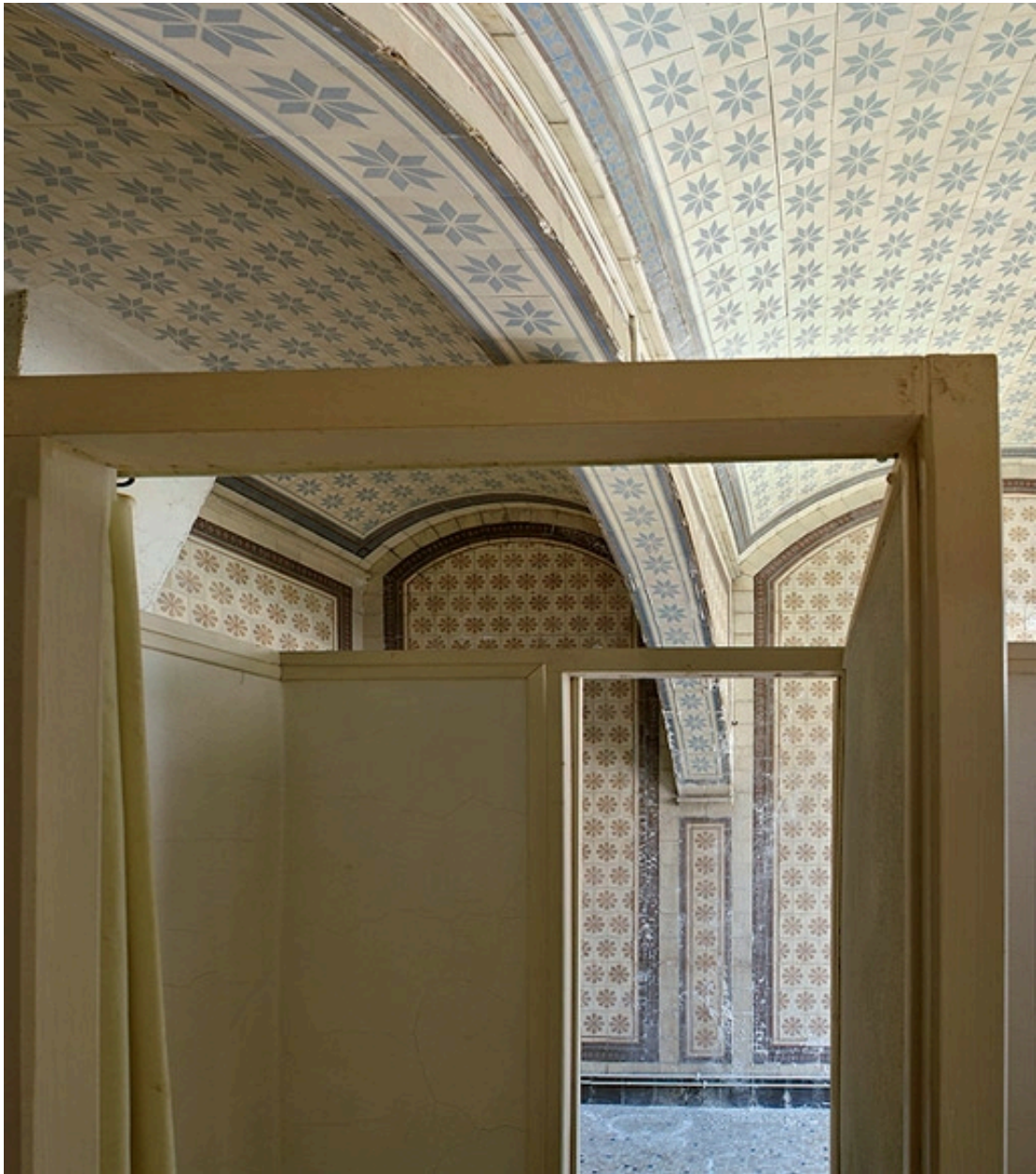
Corps central, cabinet du médecin, voûtes.
