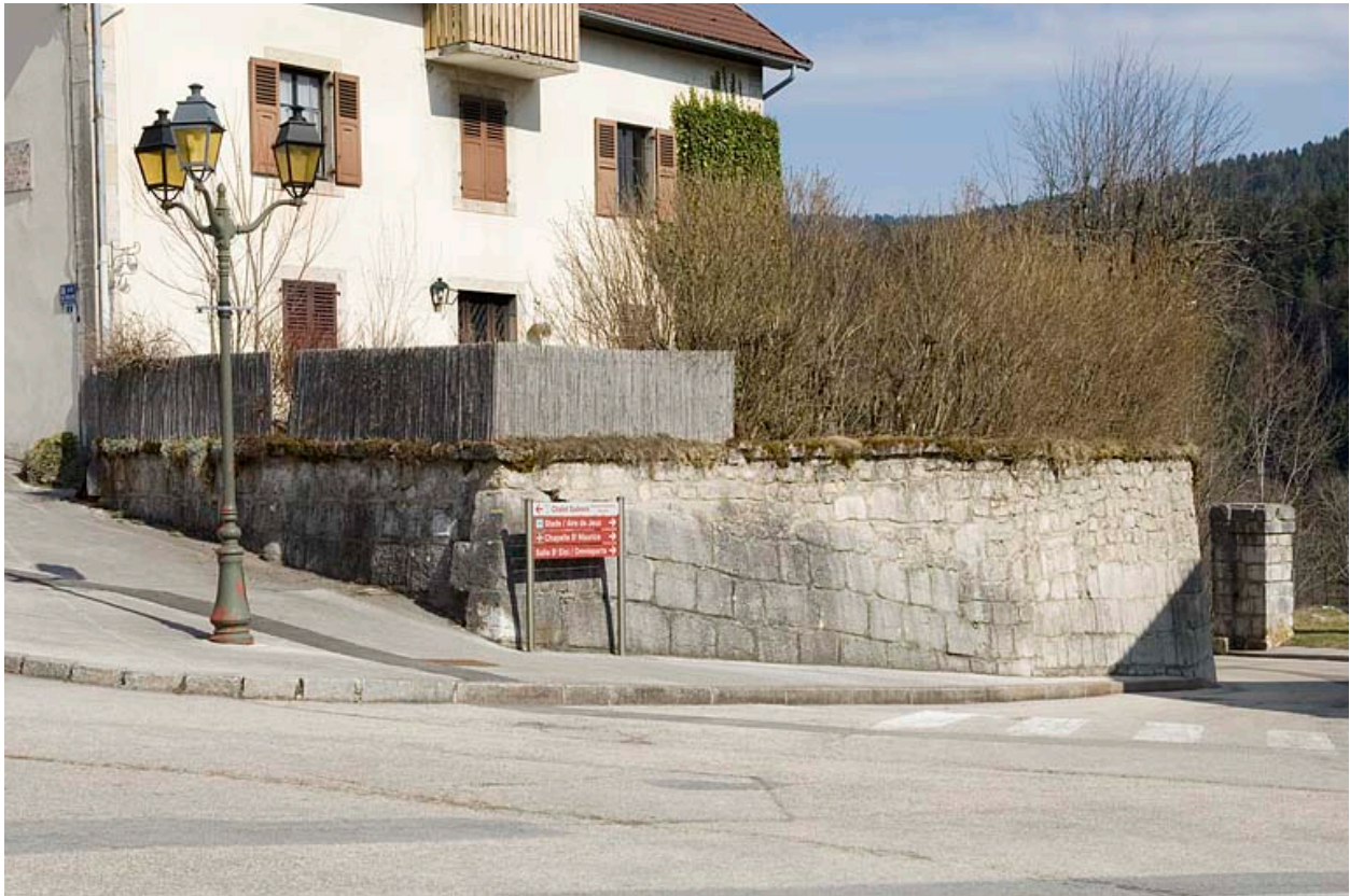
Enceinte à l'angle de la rue de l'Eglise et de la R.D. 423.
