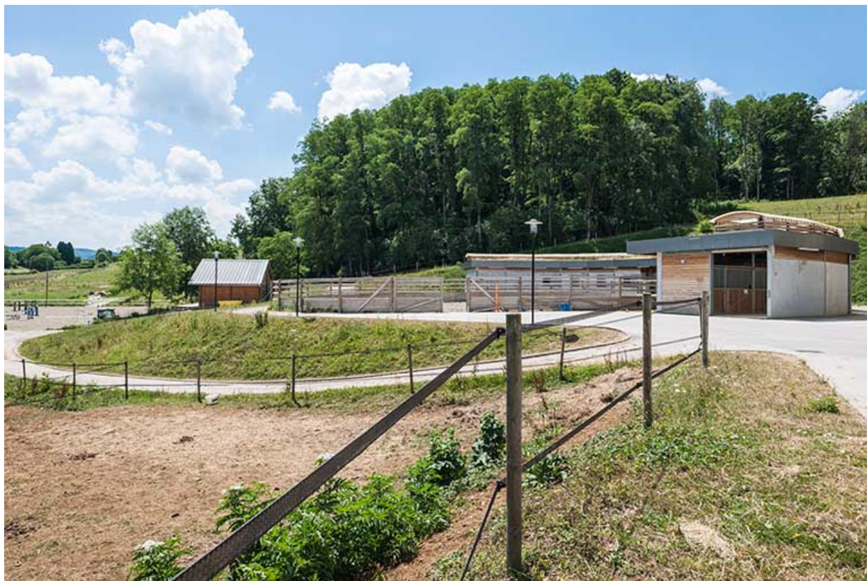
Centre équestre : terrains d'entrainement extérieurs.
