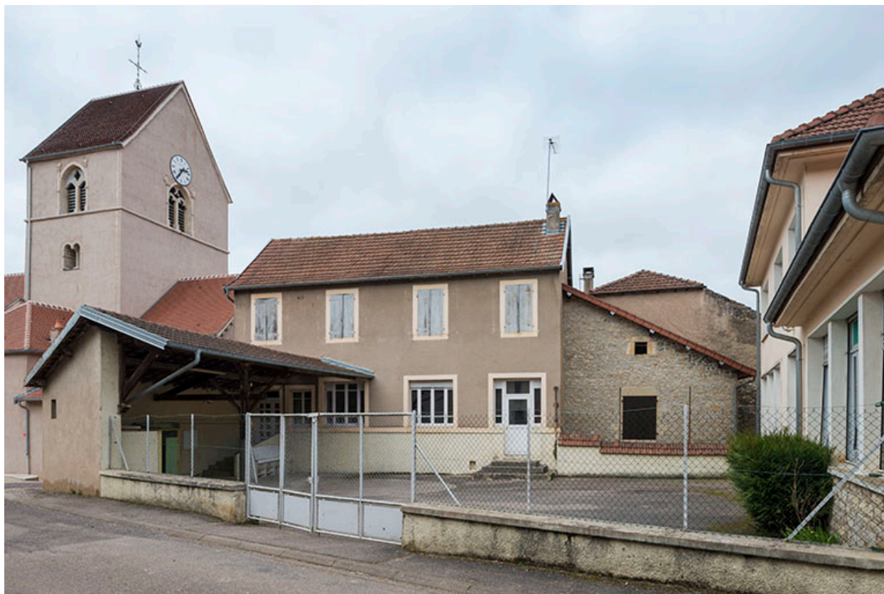
L'ancienne maison d'école des filles.
