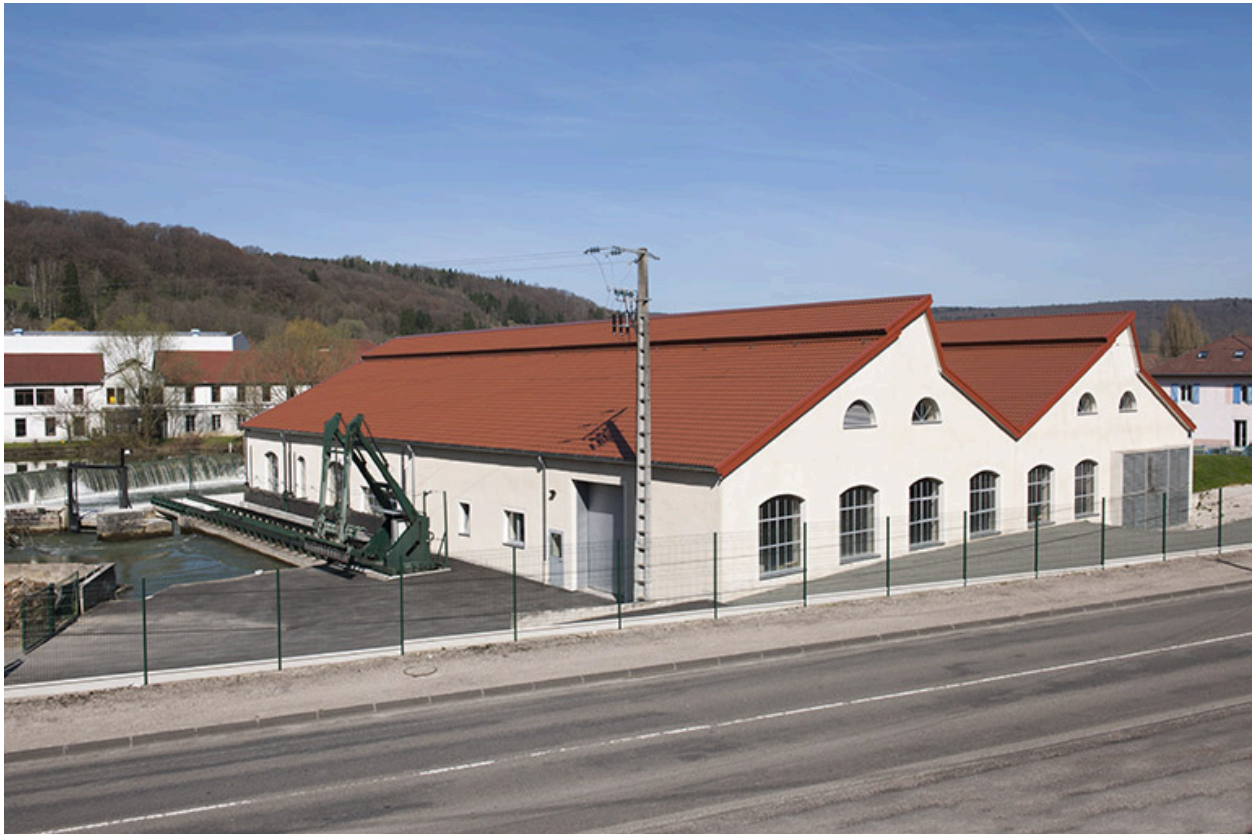
La centrale hydroélectrique vue de trois quarts.
