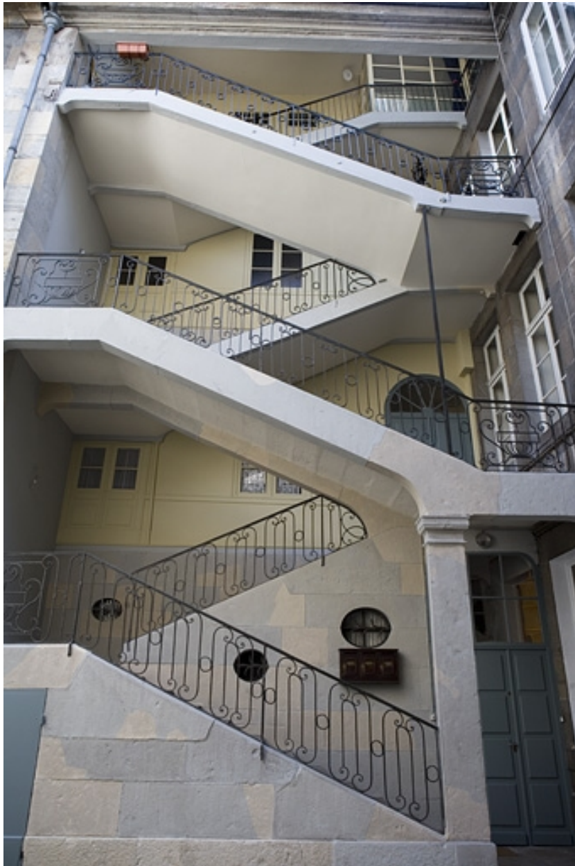
Vue d'ensemble de l'escalier à cage ouverte.
