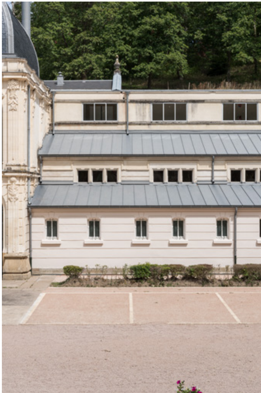
Aile sud, élévation ouest.
