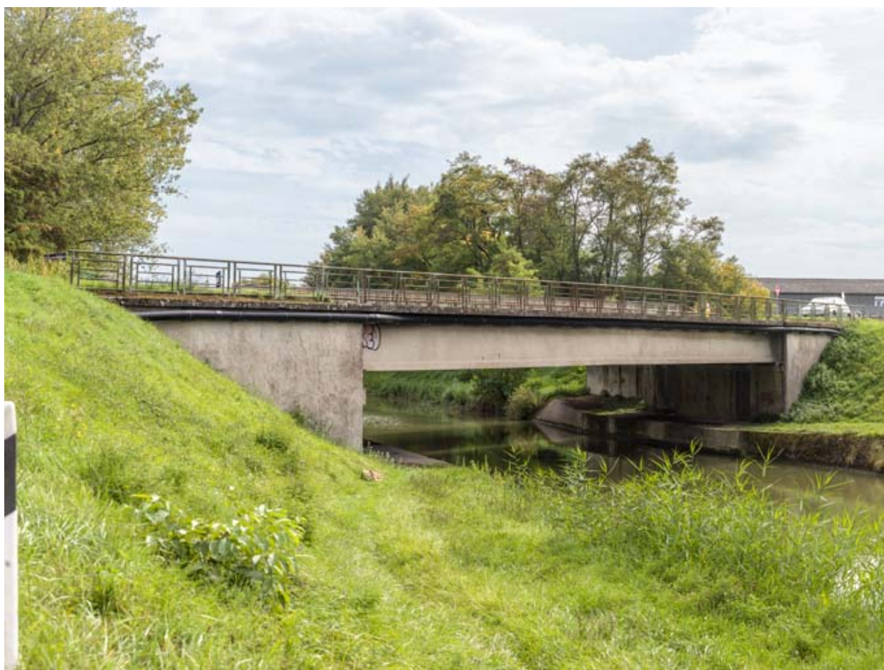
Vue d'ensemble du pont.
