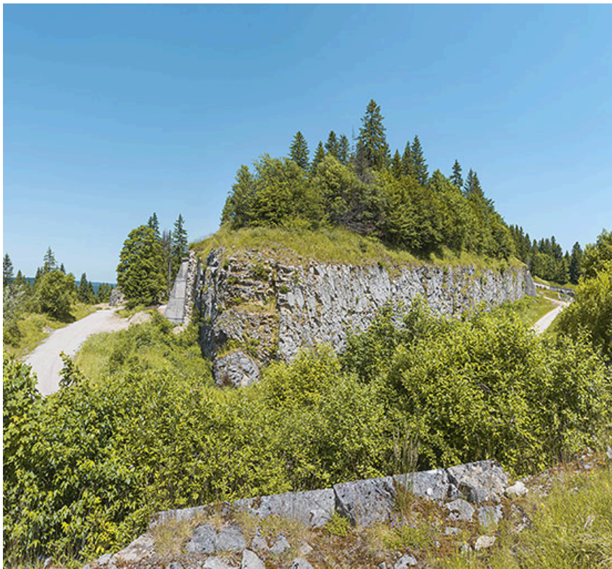
Angle sud du fort, vu depuis la contrescarpe.
