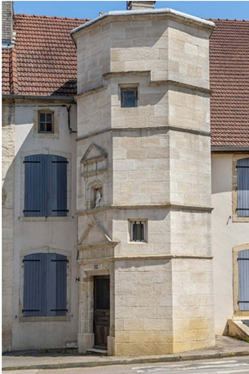
Vue rapprochée de la tour d'escalier.
