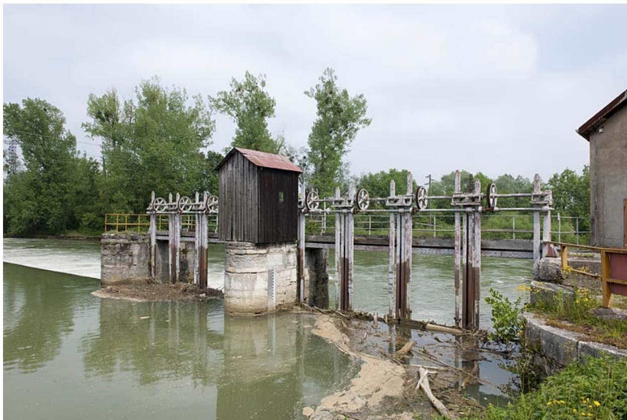
Vannage du barrage.
