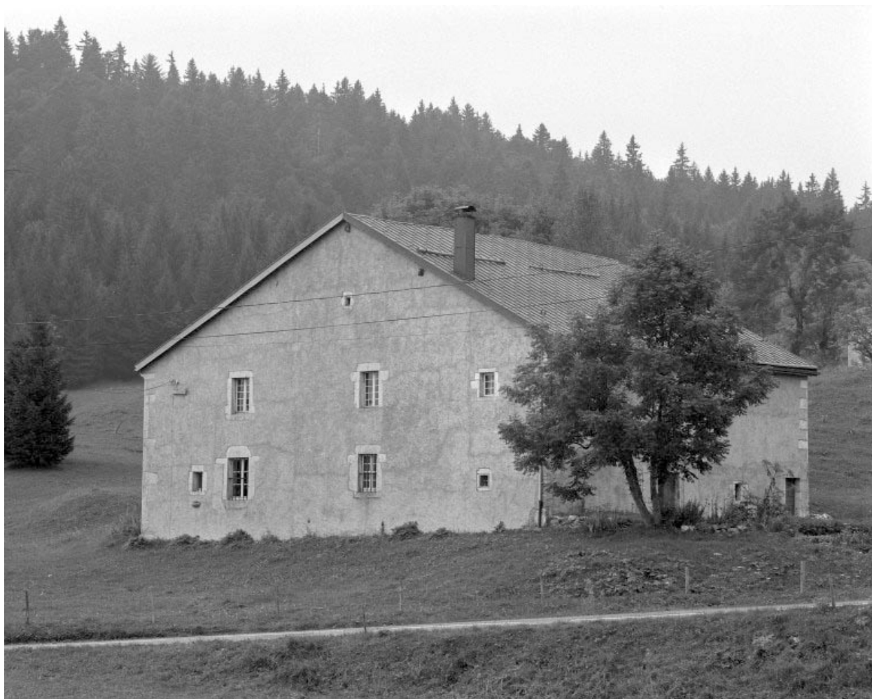
Face droite et façade postérieure.
