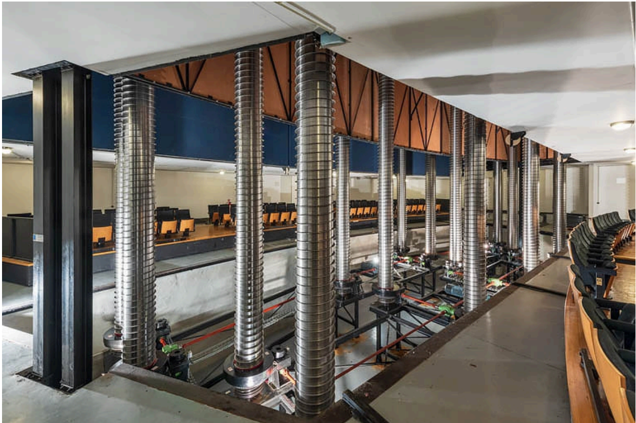
Avant-scène : vérins soutenant le plancher de la fosse d'orchestre.
