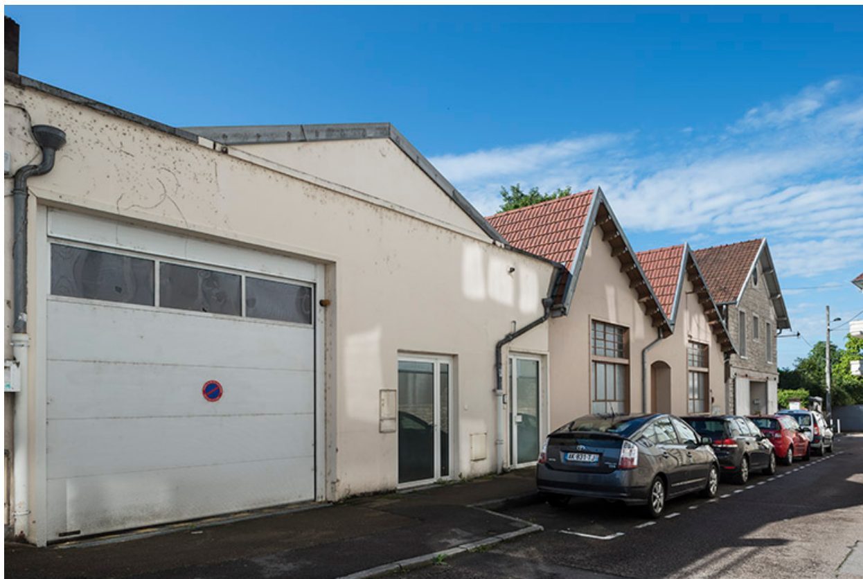
Façades postérieures (rue Klein).
