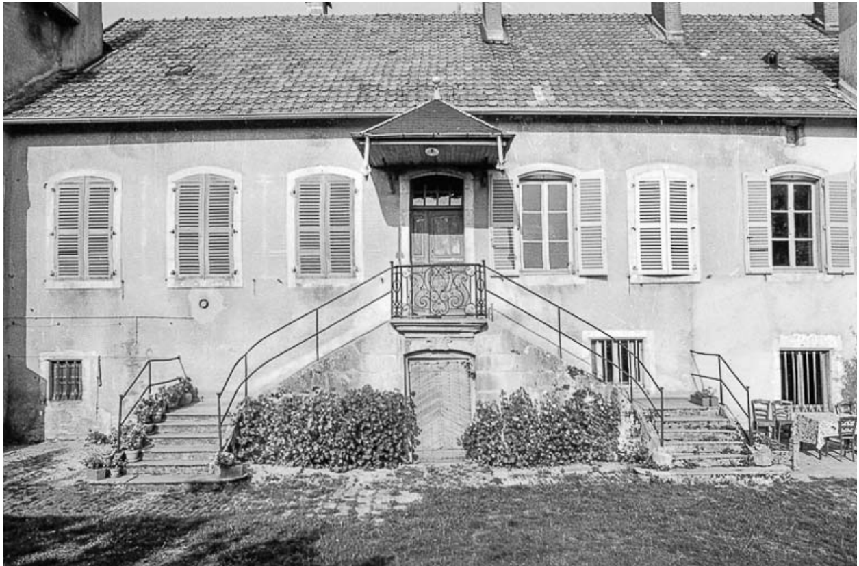
Façade antérieure et escalier à double volée.
