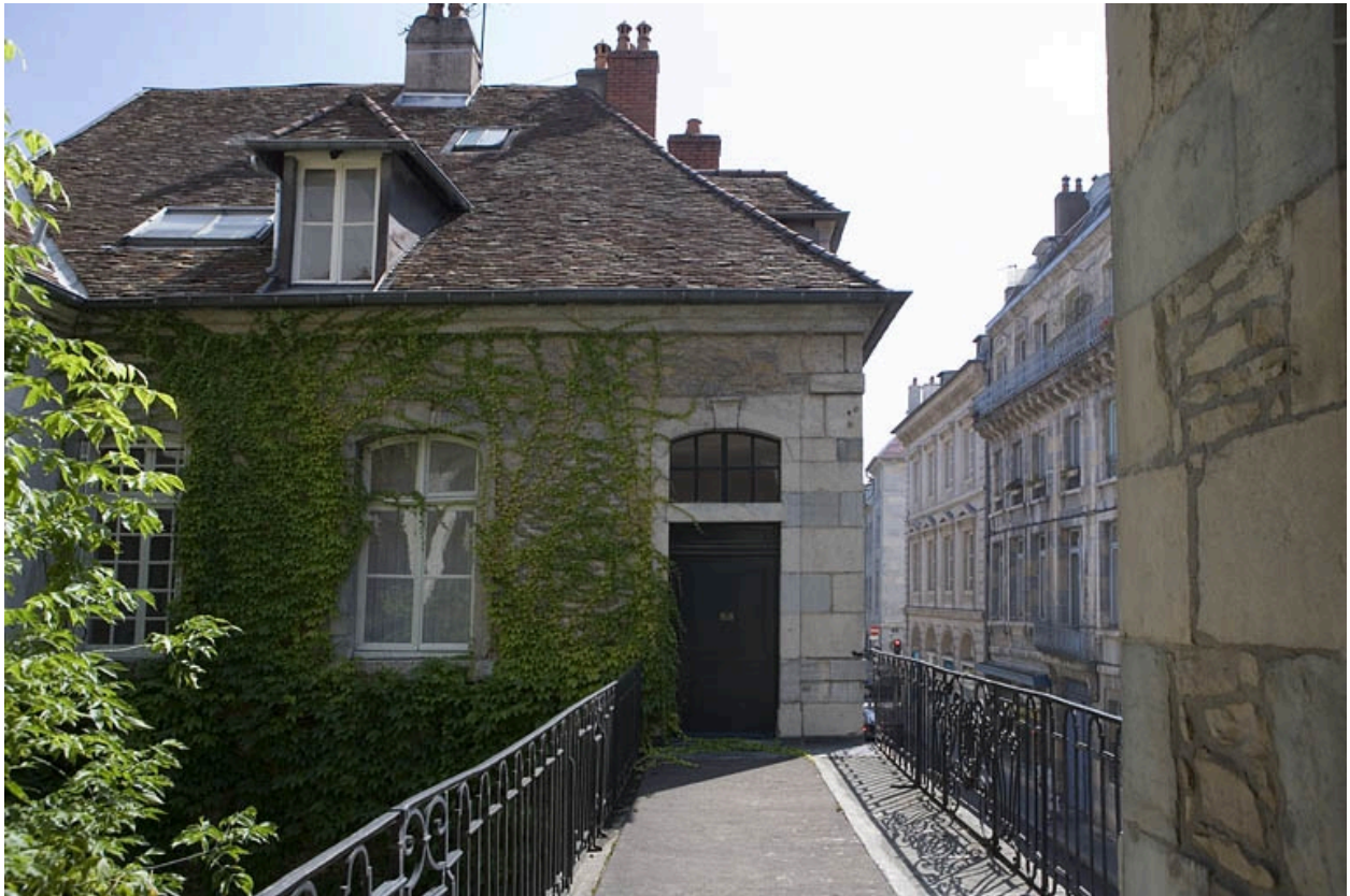
Vue du passage au-dessus du portail dans clôture depuis le bâtiment gauche.
