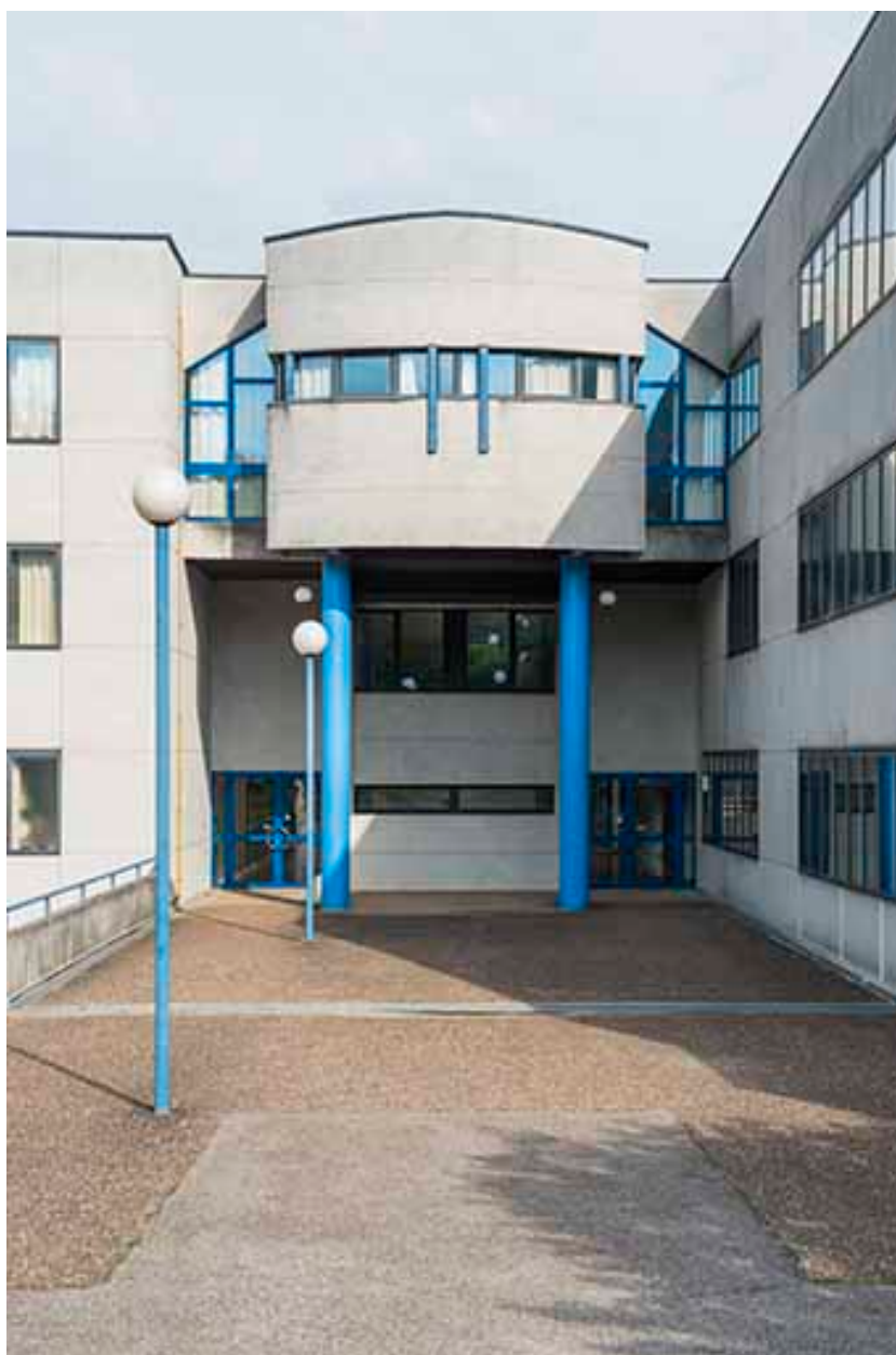
Détail de la façade sud-est, entrée postérieure.
