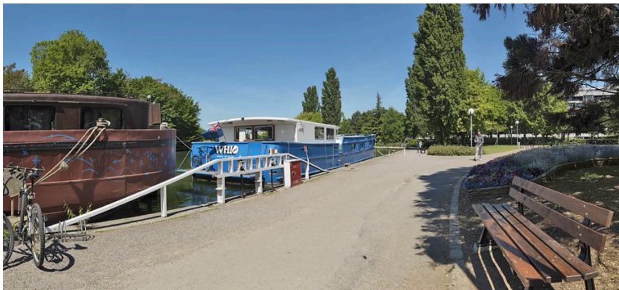
Vannes du déversoir de fond du port.
