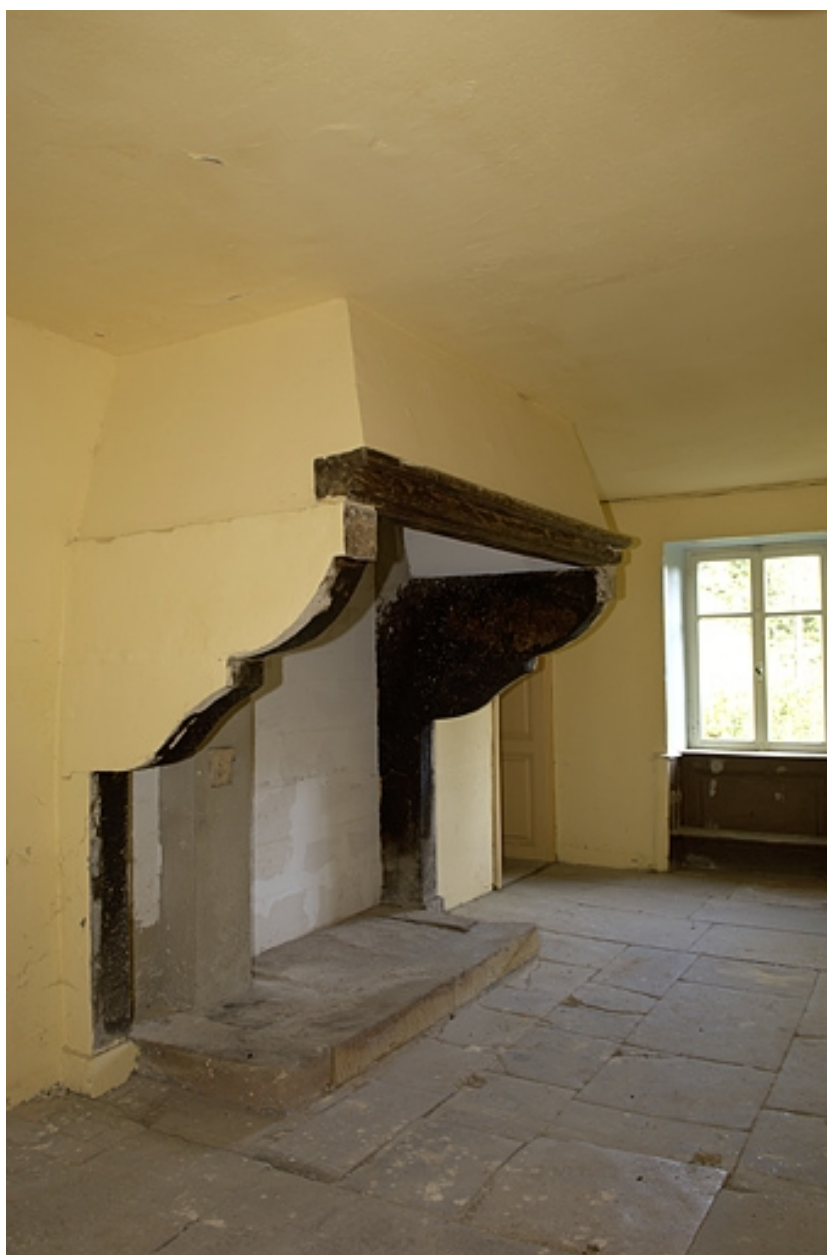
Logement. Cheminée de la cuisine.
