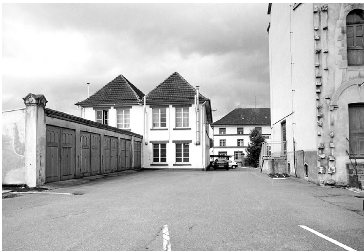
Remises et laboratoire depuis l'est.
