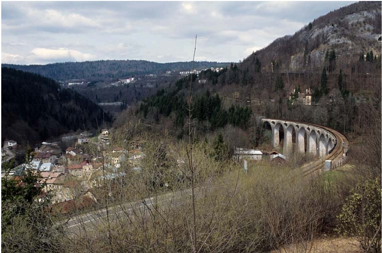
Vue d'ensemble du viaduc et de la vallée de la Bienne, depuis l'est.
