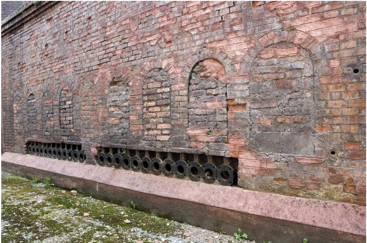
Orifices des tubes de la chaudière.
