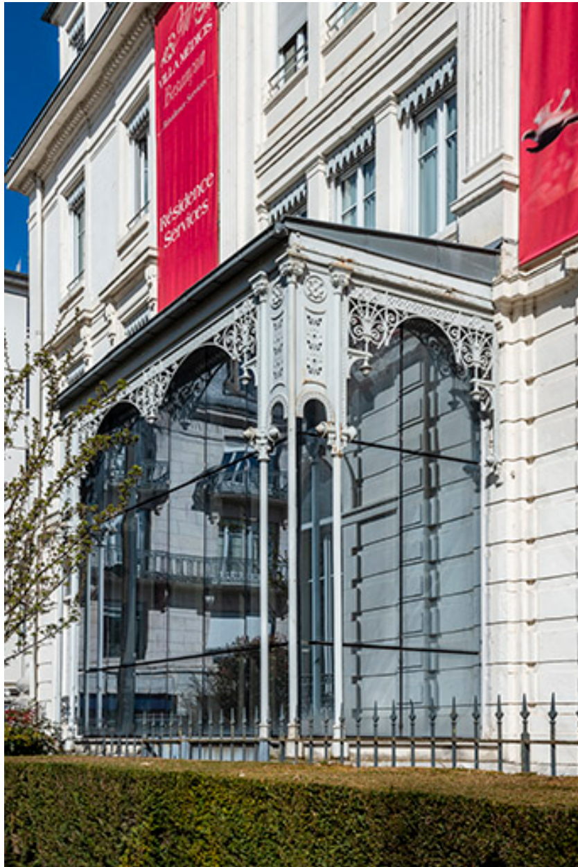
Façade sur l'avenue Édouard Droz, travées centrales, marquise de l'ancien salon mauresque.
