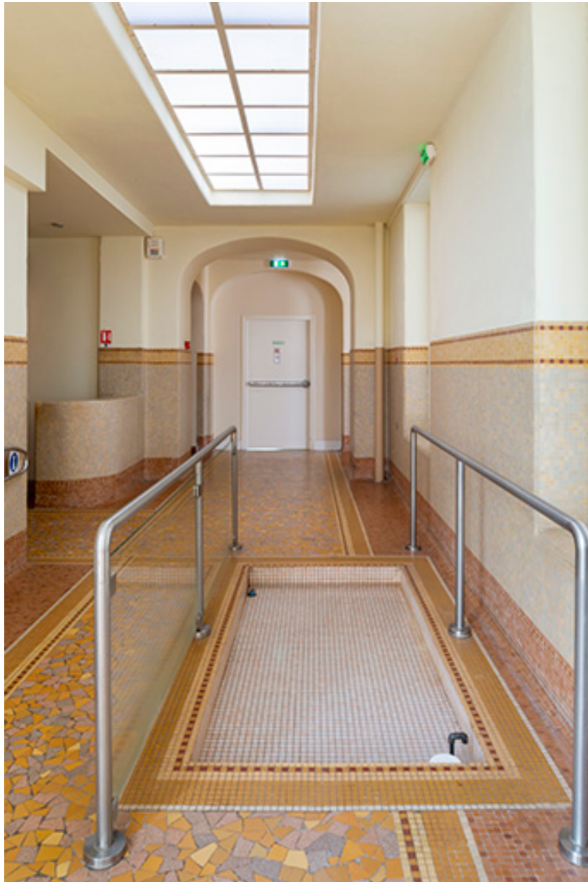
Pédiluve à la sortie des vestiaires.
