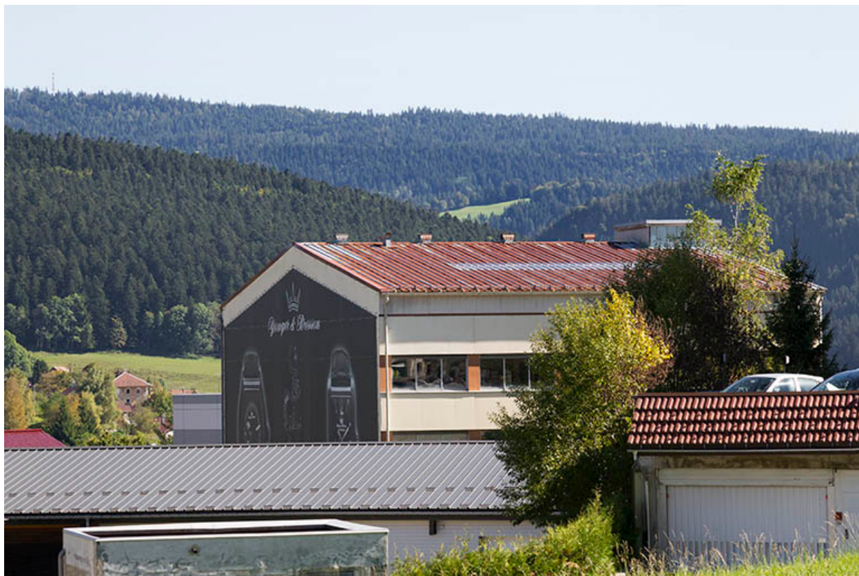
Corps nord : façades postérieure et latérale droite.
