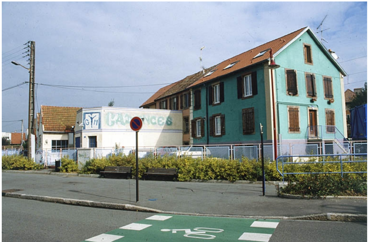
Ateliers et logements depuis le sud.
