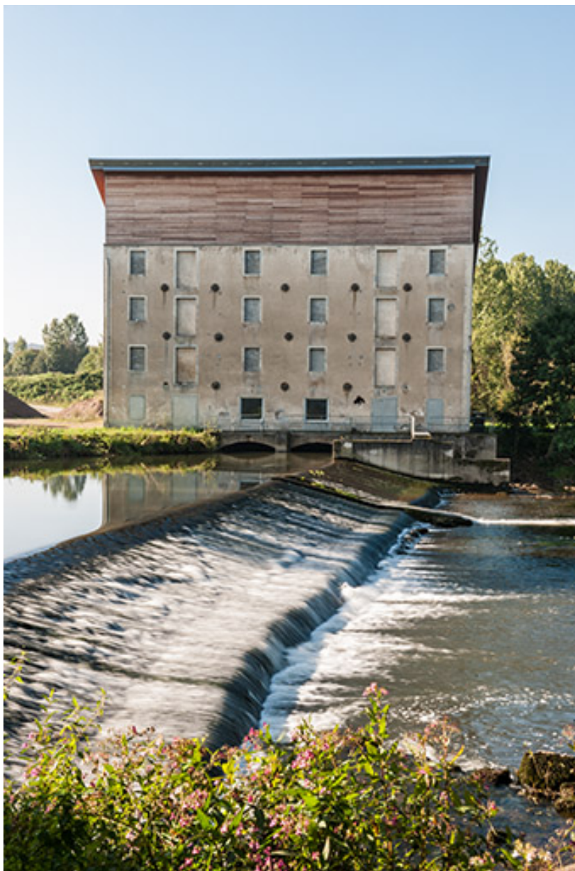
Façade nord depuis l'extrémité du barrage.
