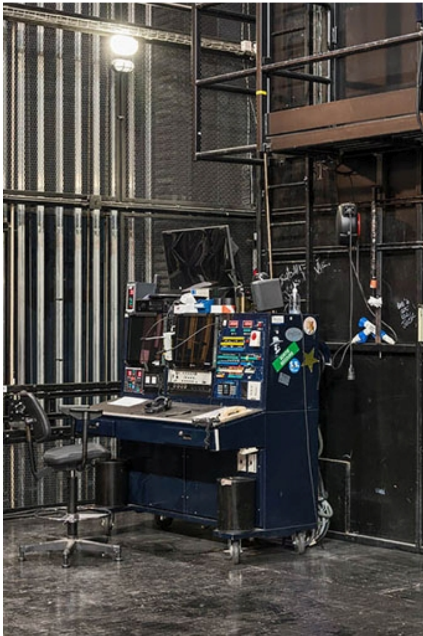
Cage de scène : pupitre de commande en coulisse.
