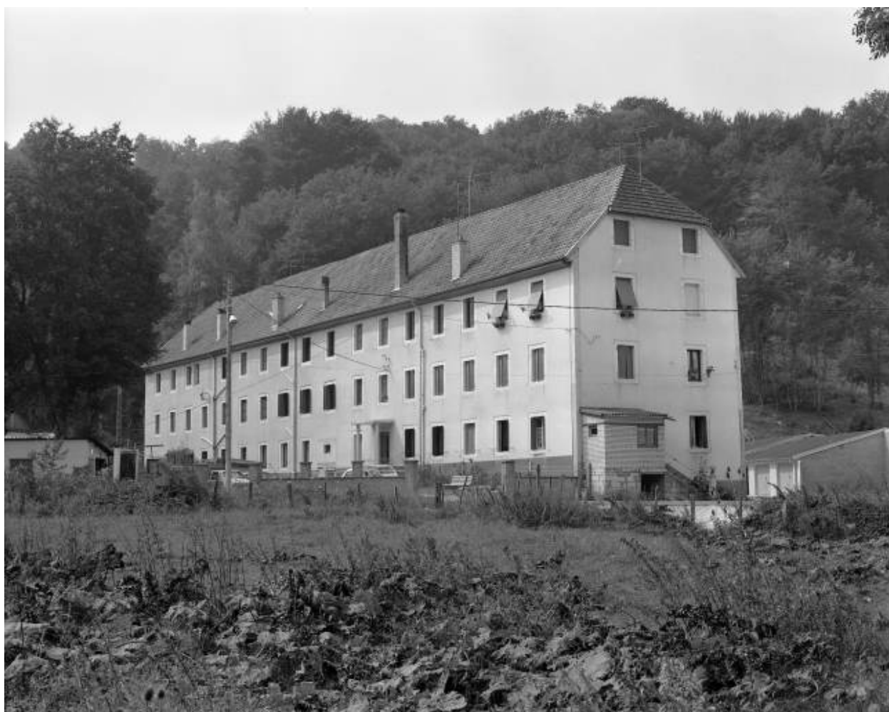
Vue d'ensemble depuis le sud-est en 1981.
