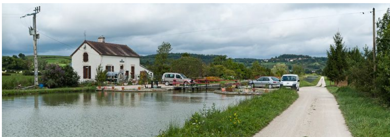
Vue du site d'écluse depuis l'amont.
