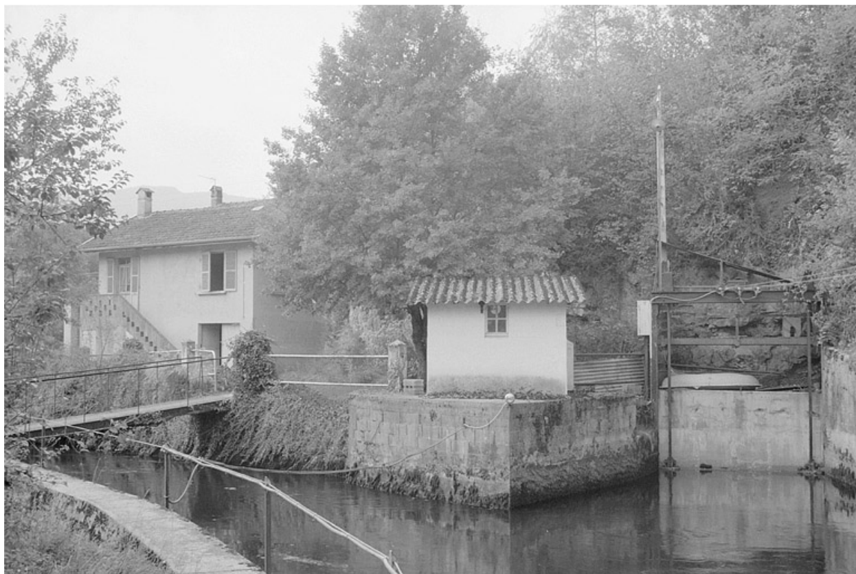
Bifurcation du canal d'amenée.
