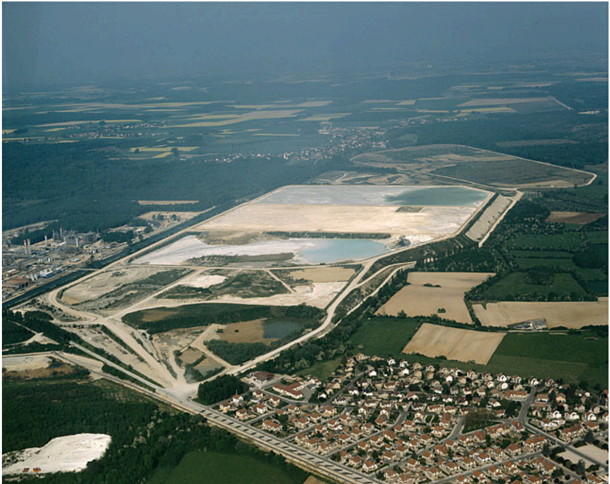
Les bassins de décantation et la cité ouvrière de Damparis vus de l'est, photographie aérienne.
