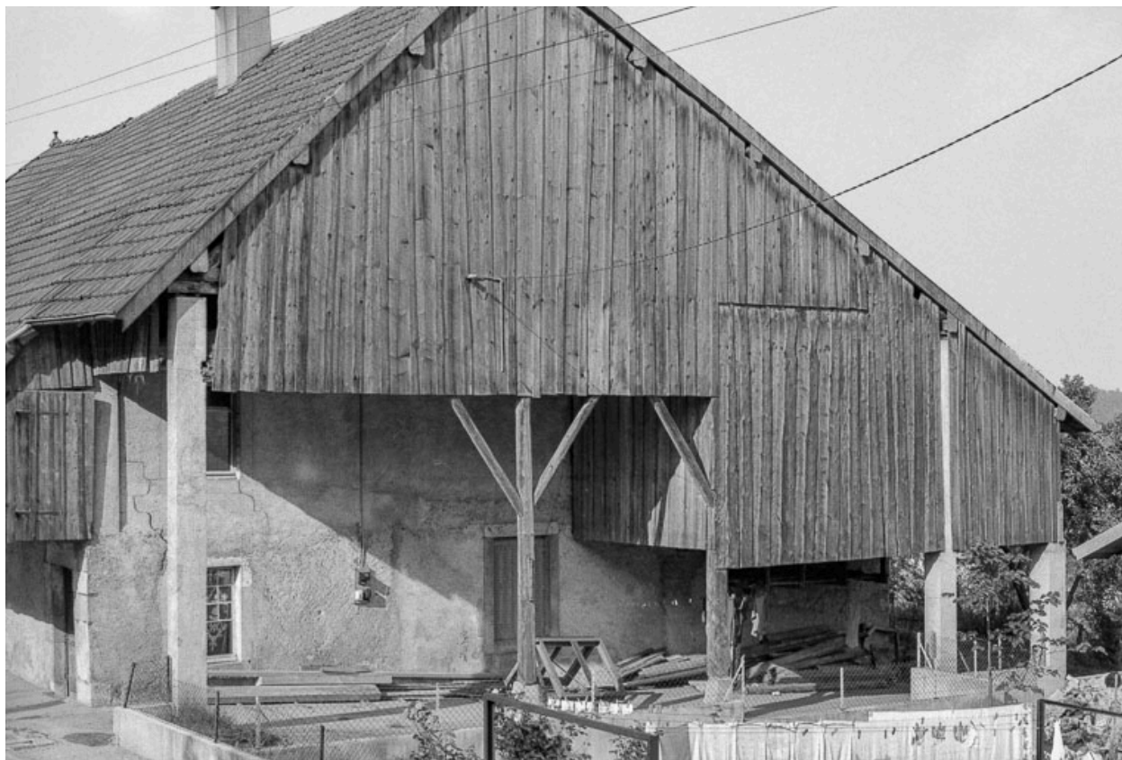
Ferme cadastrée 1962 E 189 : façade latérale droite.
