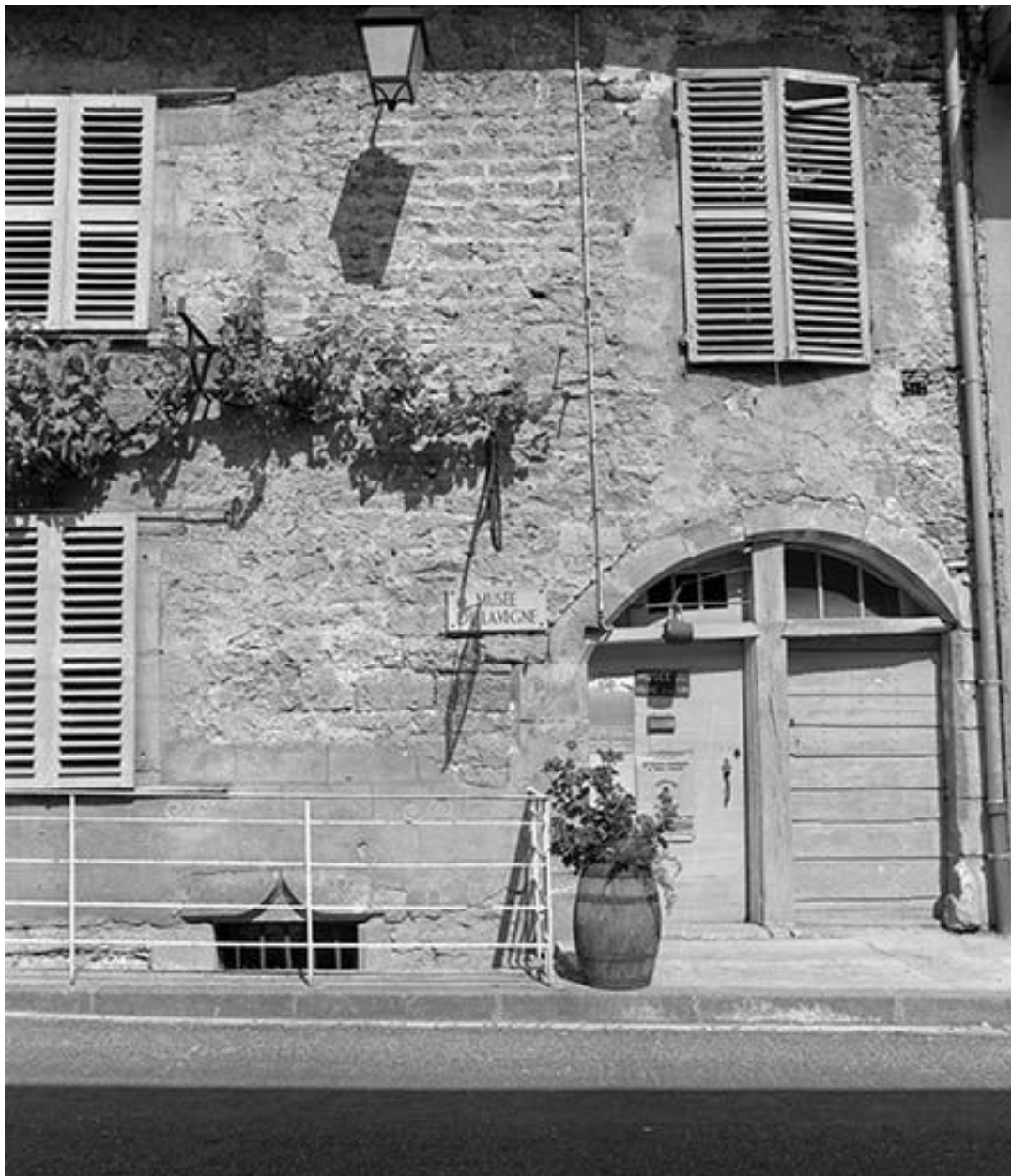
Détail de la façade antérieure : l'entrée.
