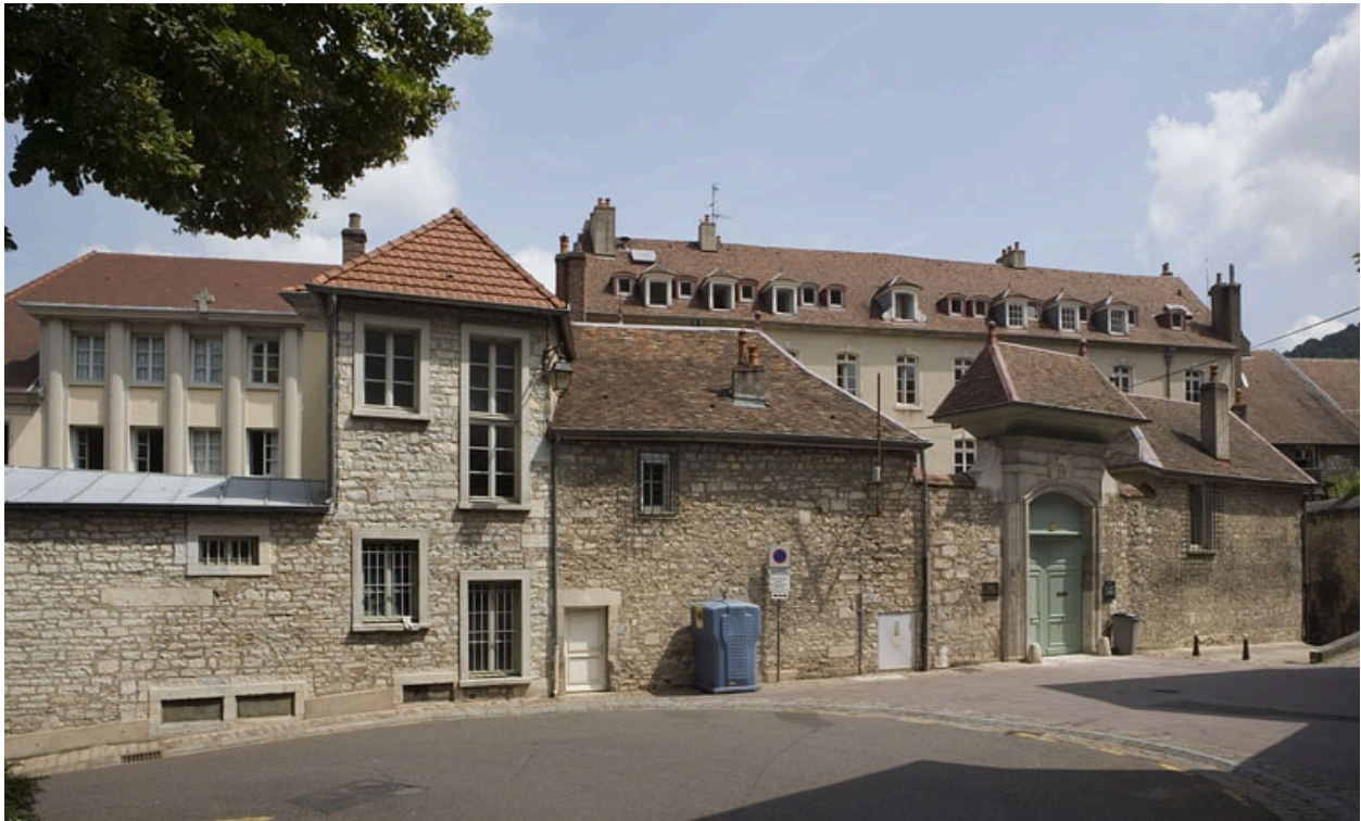
Vue d'ensemble rapprochée de la clôture et du portail depuis la rue.
