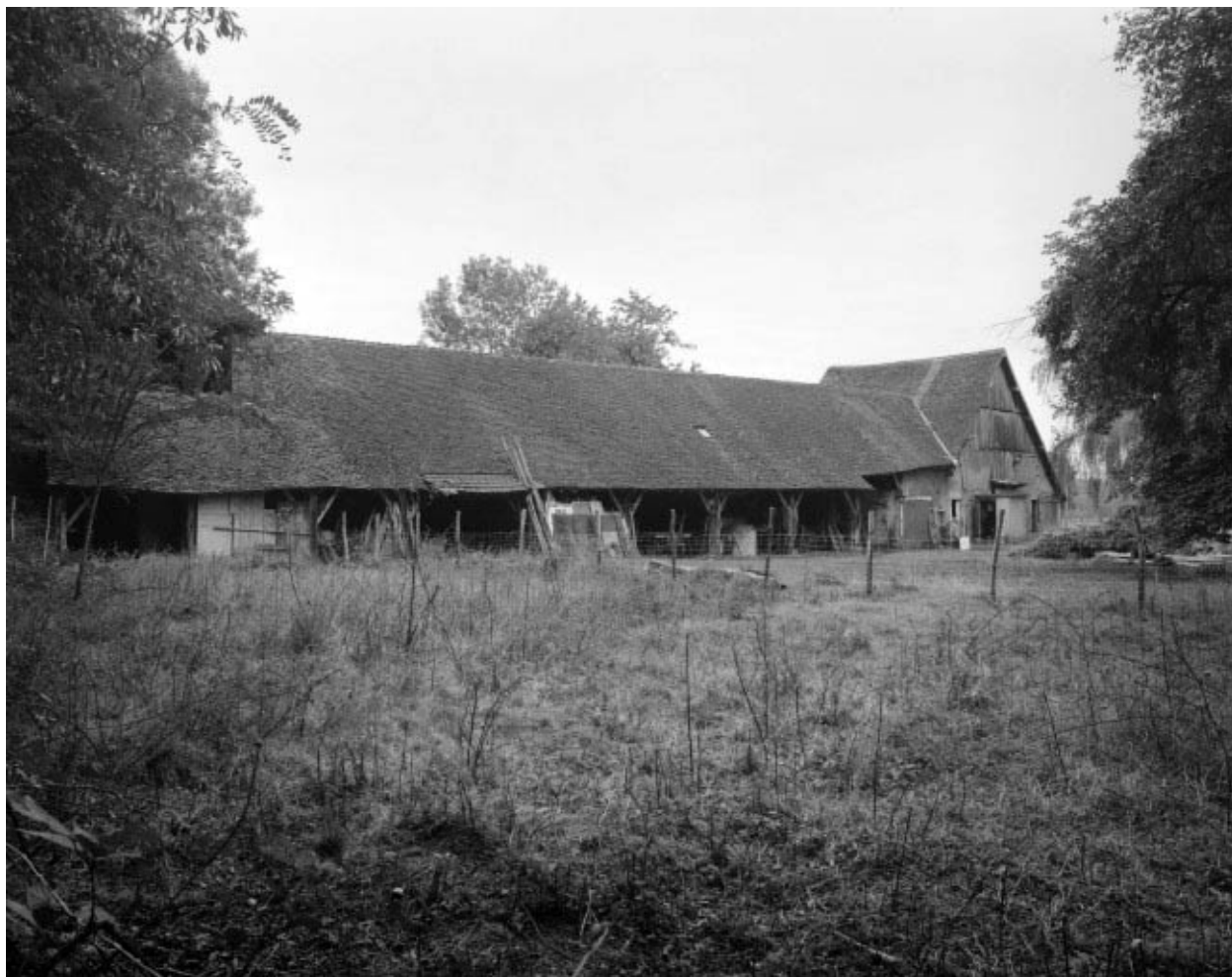
Pièce de séchage depuis le nord-ouest.
