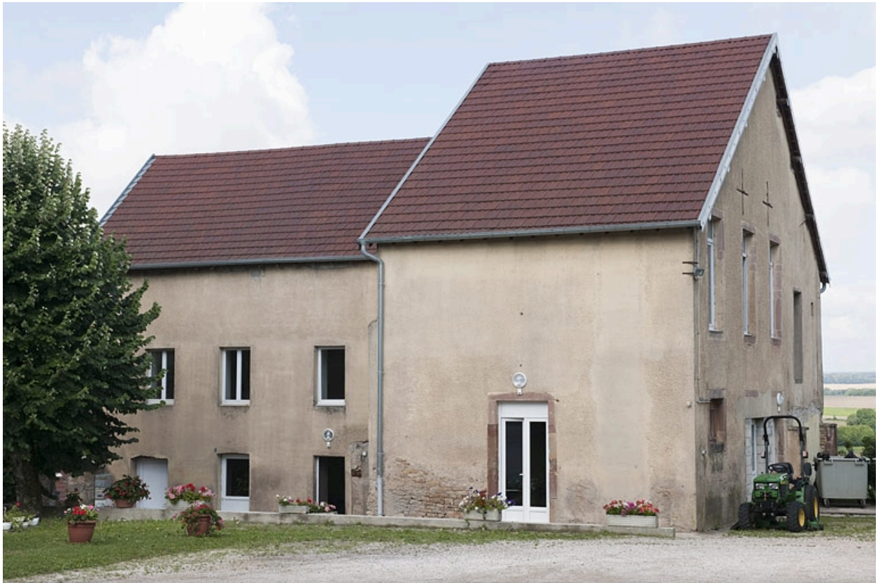
Bâtiment (B), vue d'ensemble depuis la cour.
