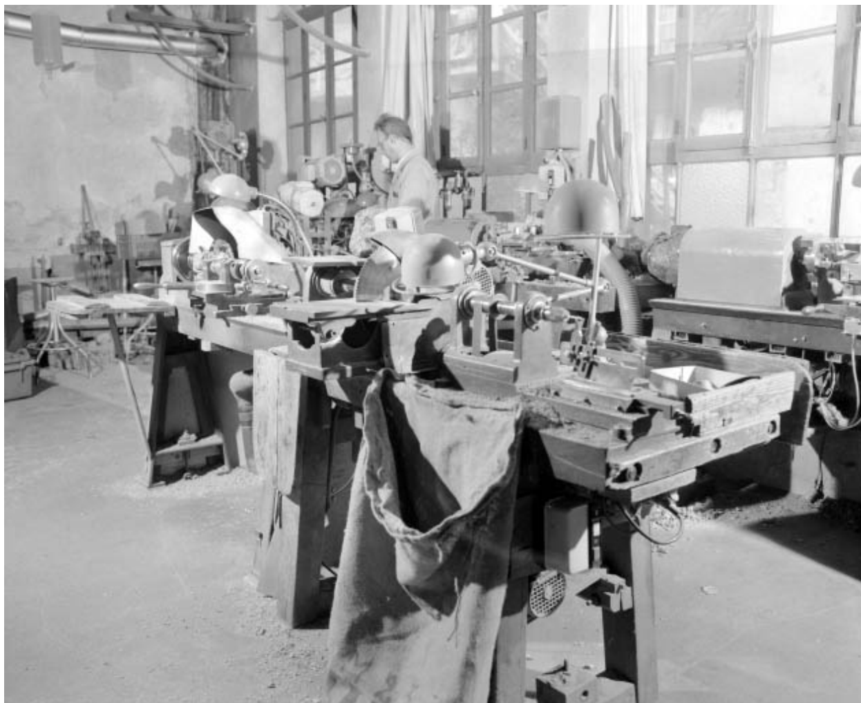
Intérieur de l'atelier de fabrication.
