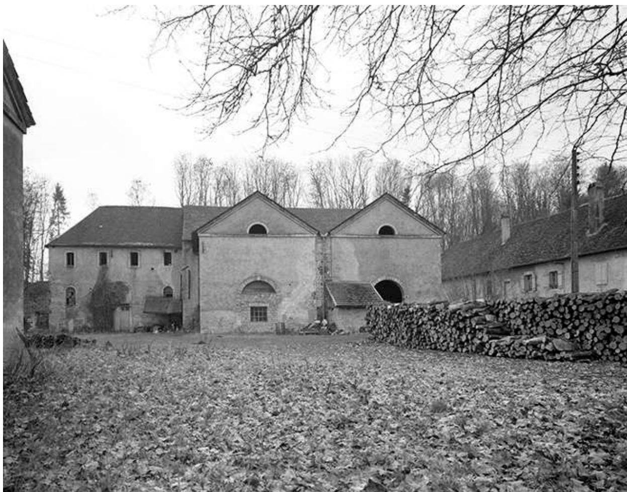
Le haut-fourneau vue de face en 1985.
