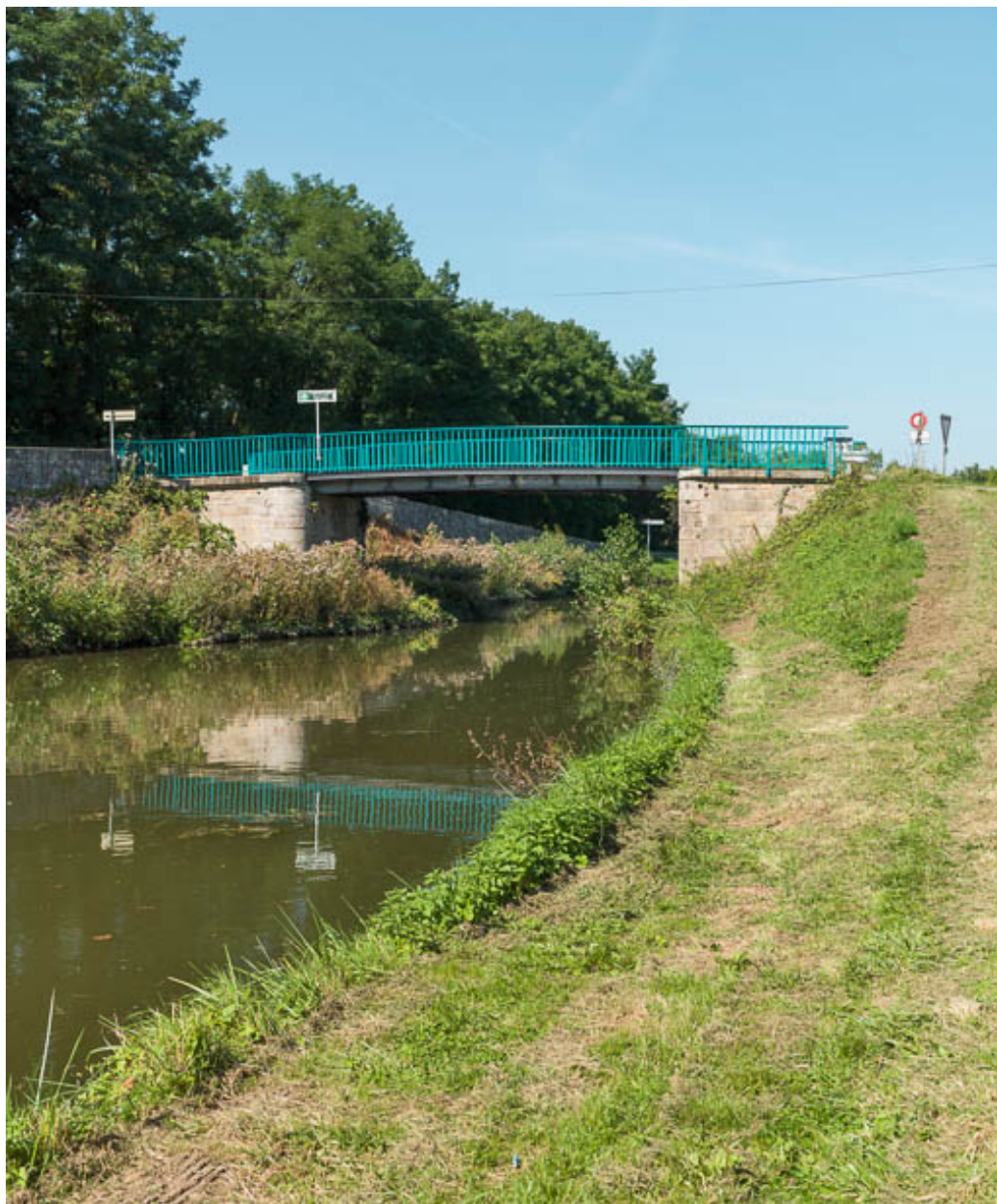
Vue d'ensemble du pont.
