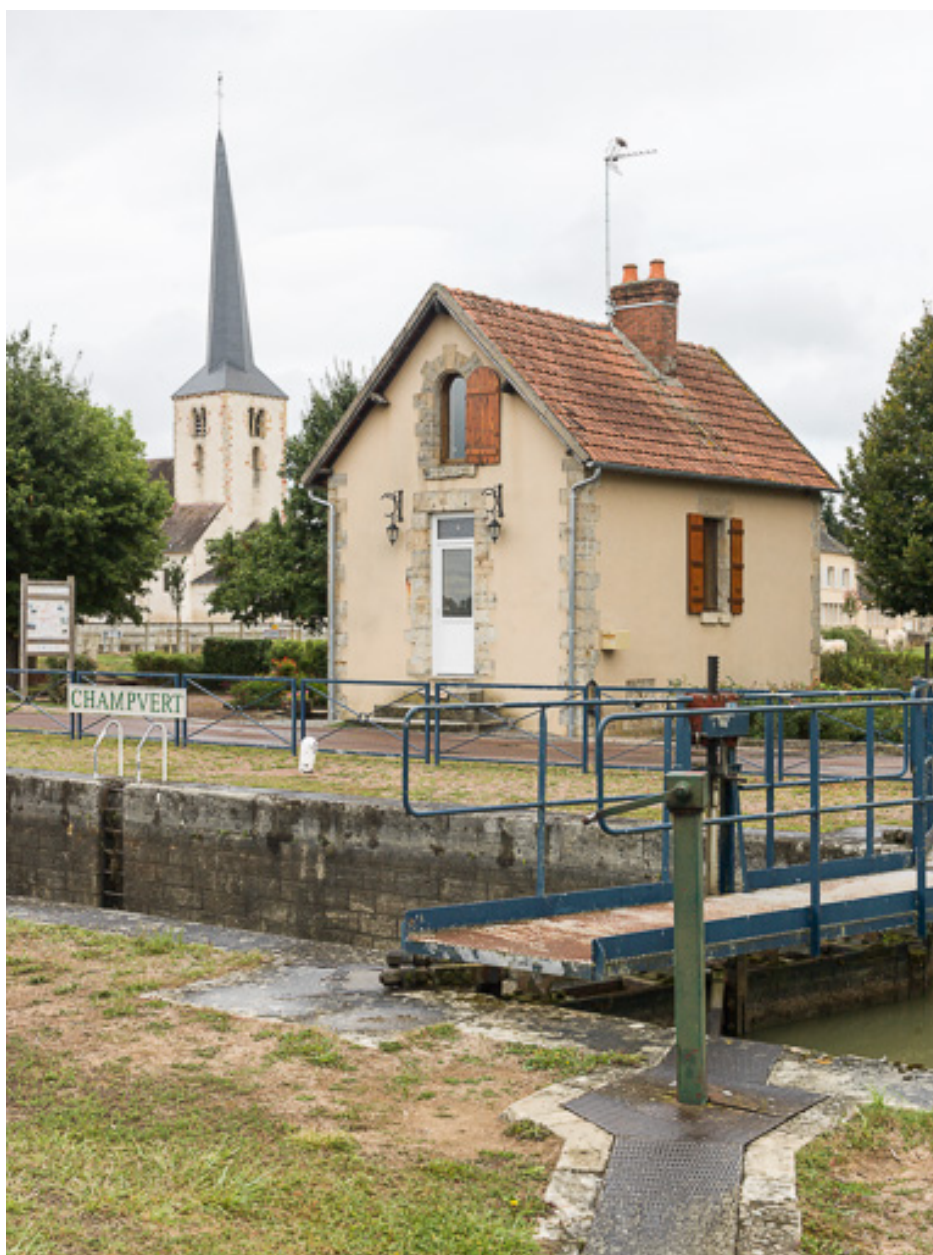
Le sas et la maison éclusière.
