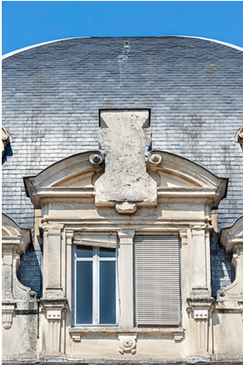
Bâtiment d'entrée, façade antérieure : lucarne attique et bloc en attente de sculpture.
