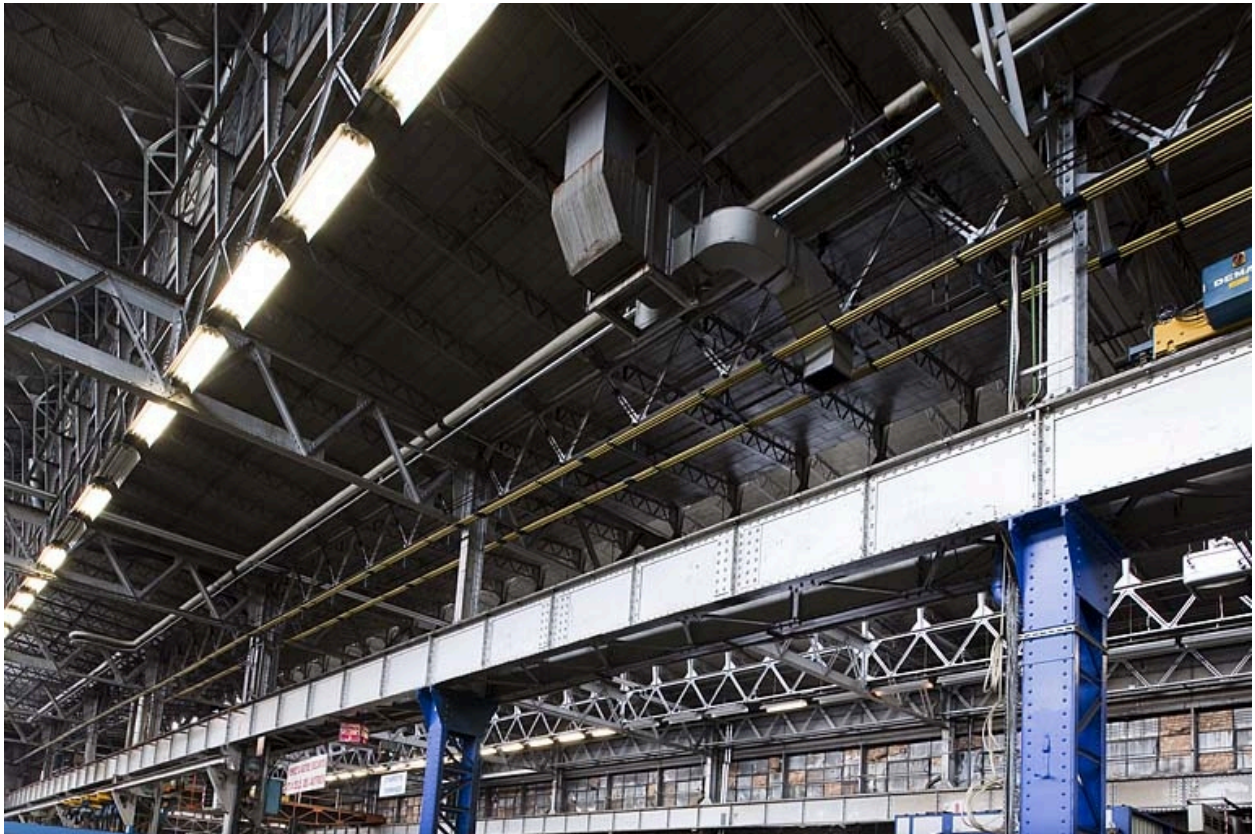
Atelier à ossature métallique. Vue de trois quarts.
