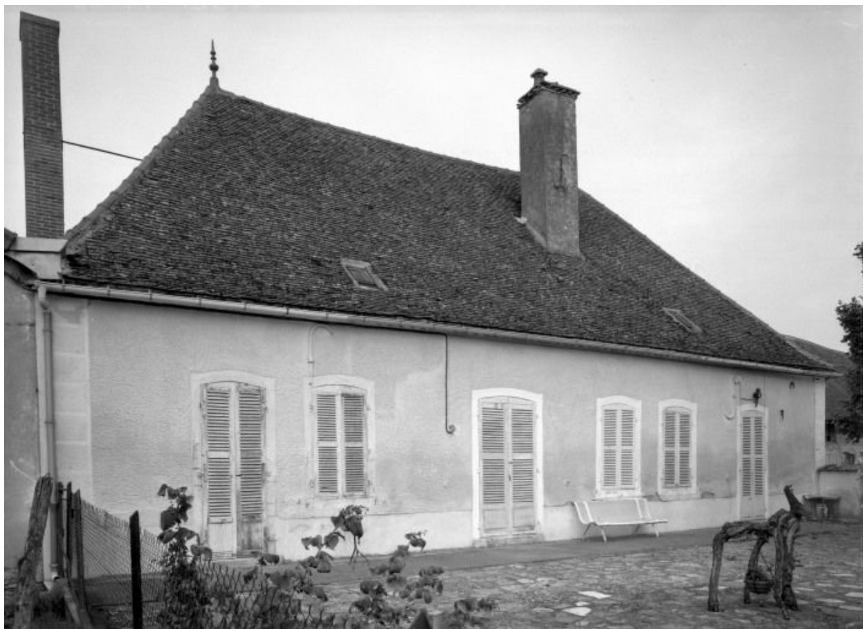
Bâtiment d'habitation, façade sur jardin.
