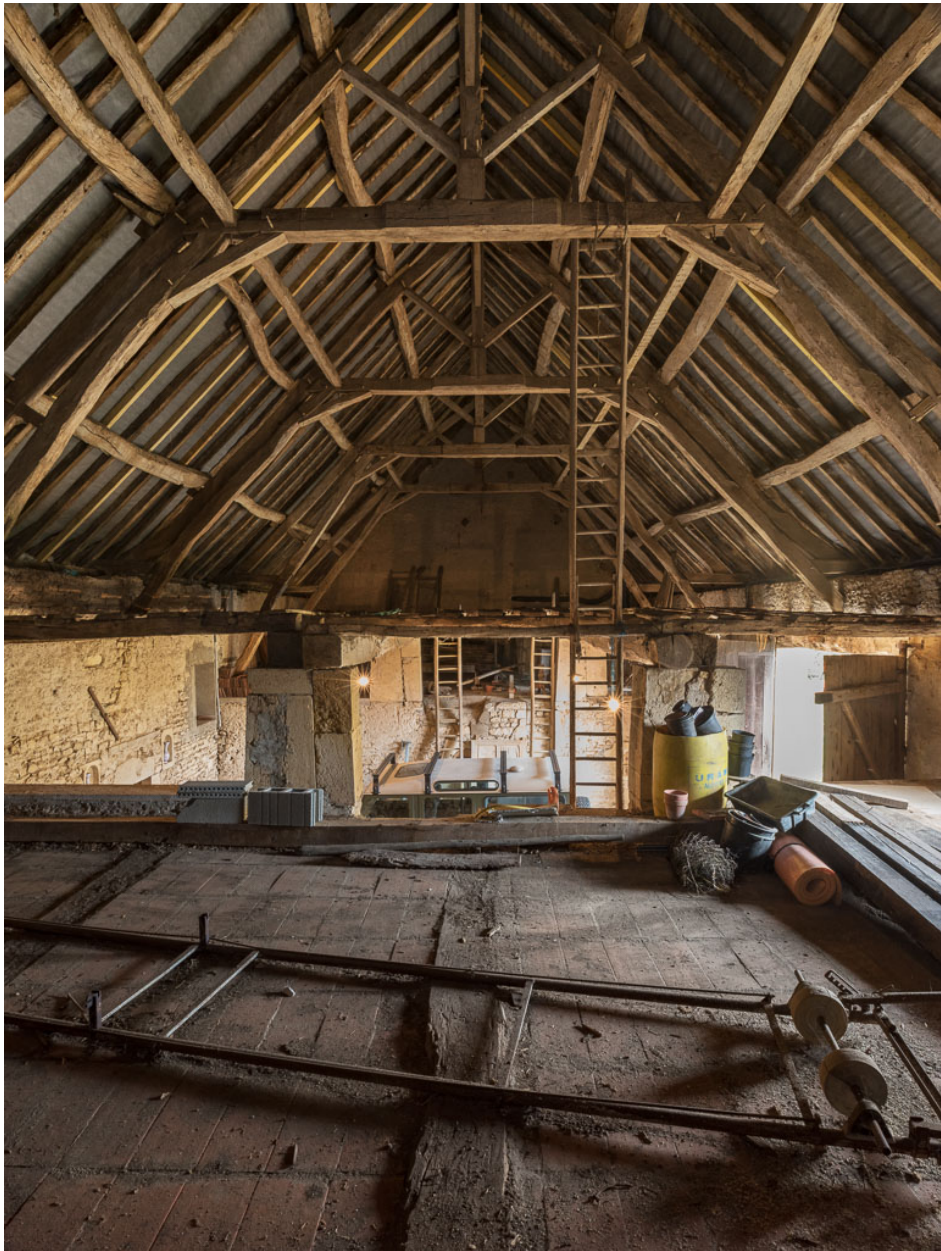
Charpente de la grange, construite en 1831.
