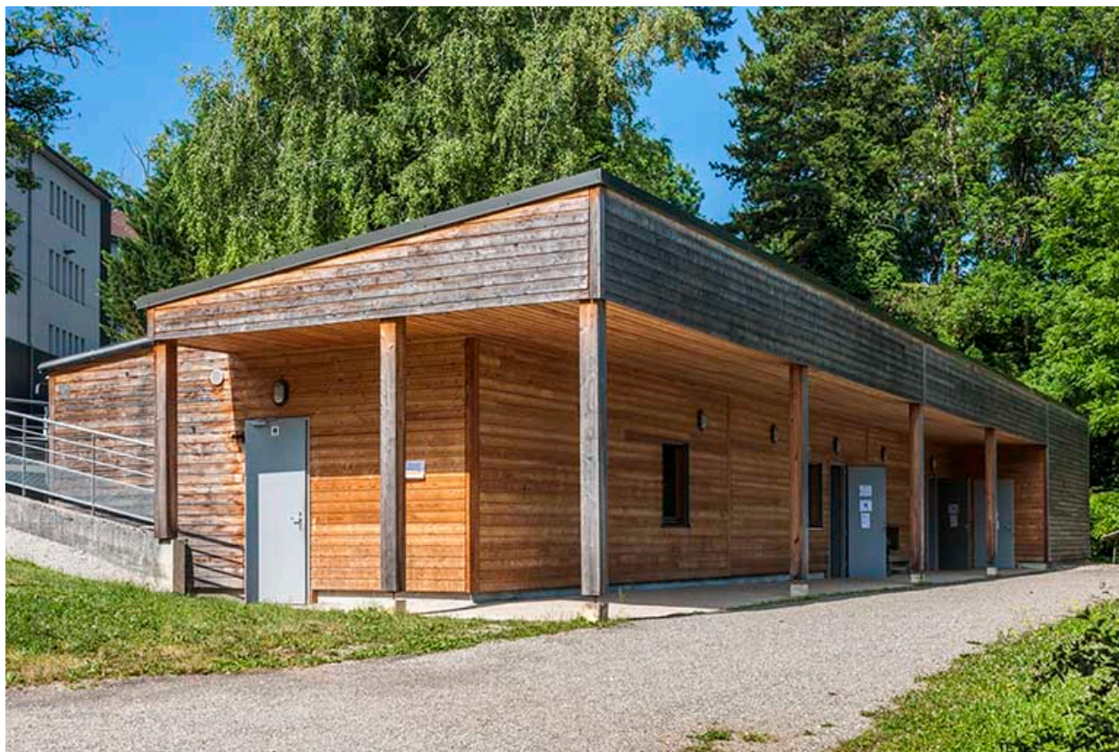
Externat : façade antérieure du préfabriqué rénové.
